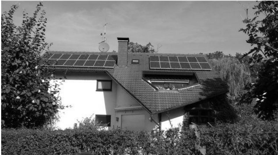
Рис. 2. Сонячні модулі з успіхом вписуються в архітектуру вже існуючих будівель і споруд м. Мадрид (Іспанія)
